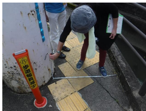
歩道の幅員の確認
