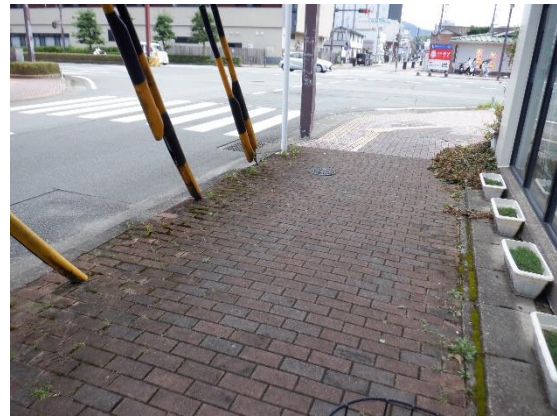
歩道（本町宮川堤線：市-1） 視覚障がい者誘導用ブロックが設置されていない。
