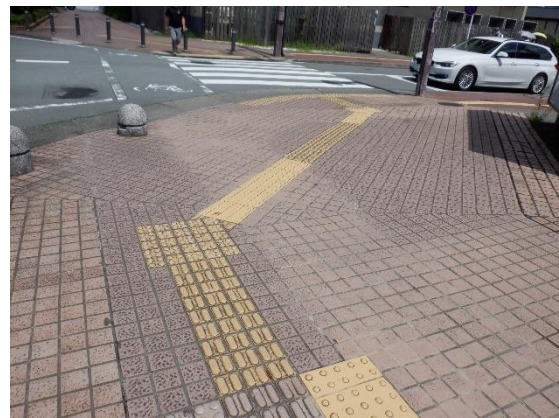
歩道（鳥羽松阪線） 種類の異なる視覚障がい者誘導用ブロック が混在している。
